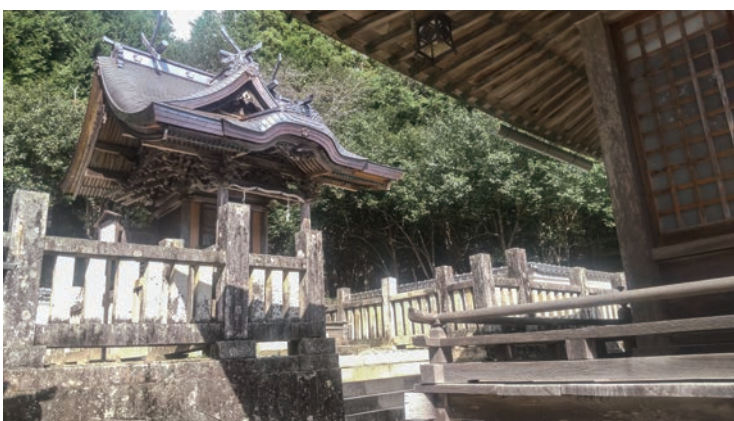
本殿と拝殿を結ぶ「渡殿」建築予定地
