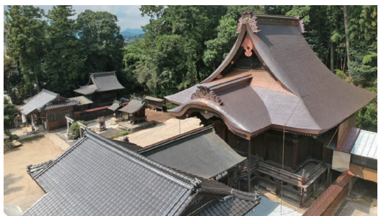
令和元年 修繕を終えた本殿
