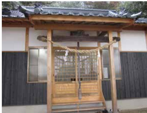
柱は全てフシのない檜材を使い壁は漆喰
