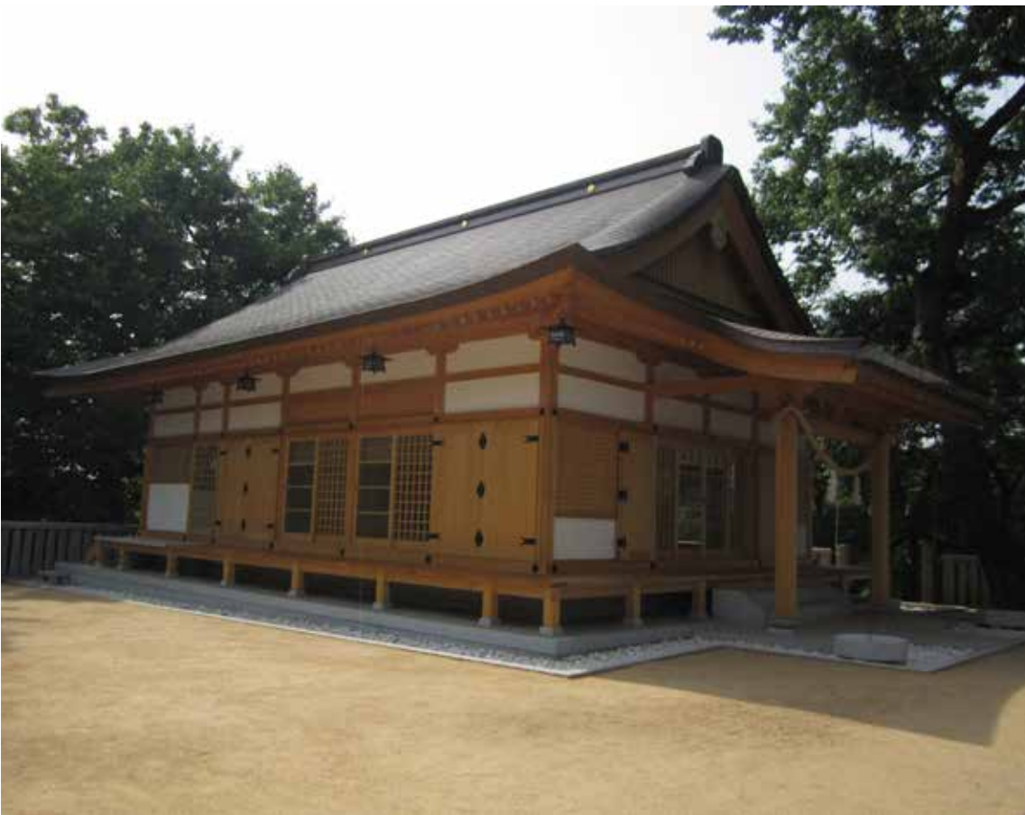
新たに造営された祈祷殿
